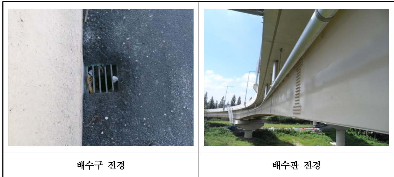
【사진 17.3.21】 배수시설 전경
