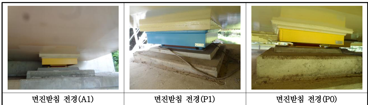
【사진 17.3.12】 교량받침 전경
