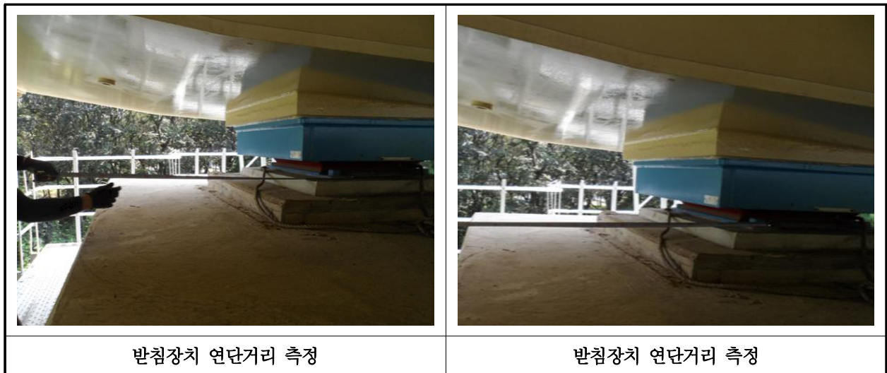
【사진 17.3.14】 교량받침장치 연단거리측정
