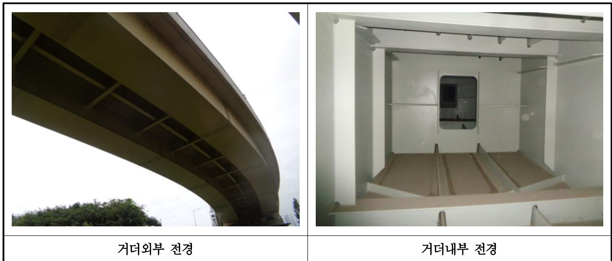
【사진 17.3.4】 거더 전경
