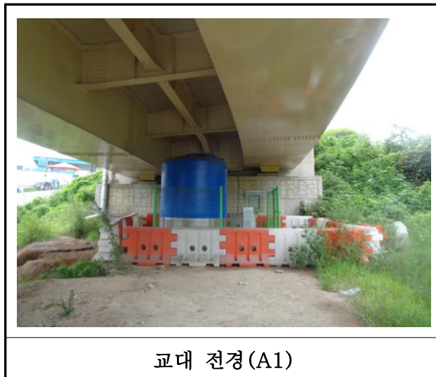
【사진 17.3.8】 교대 전경
