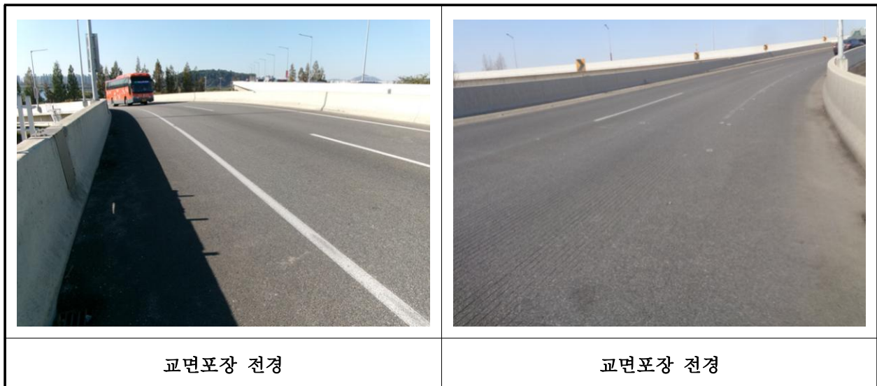
【사진 17.3.19】 교면포장 전경
