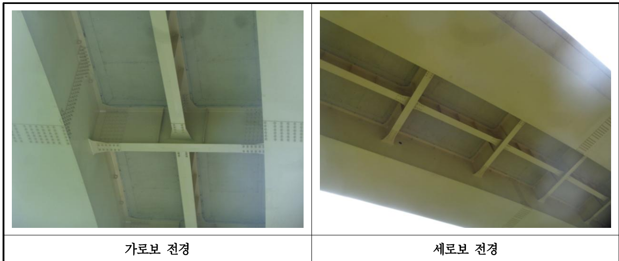
【사진 17.3.6】 가로보 및 세로보 전경
