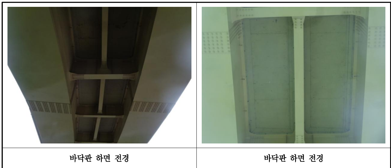
【사진 17.3.2】 바닥판하면 전경
