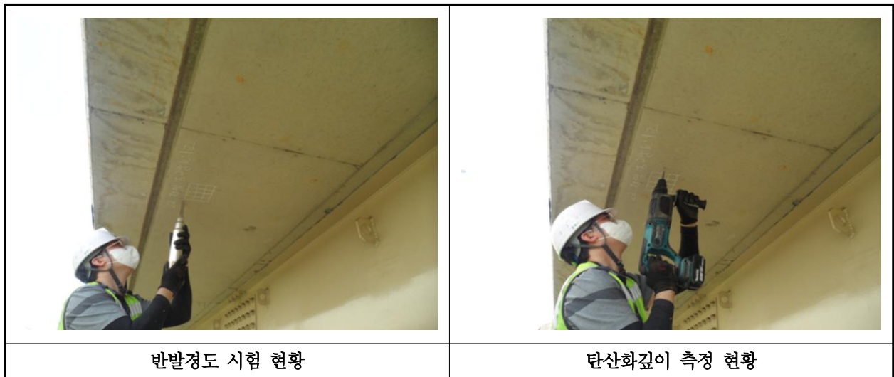
【사진 17.4.1】 콘크리트 내구성조사 현황
