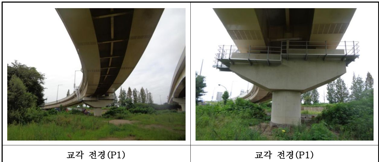
【사진 17.3.10】 교각 전경
