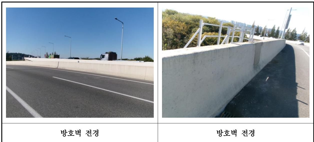
【사진 17.3.23】 방호벽 및 중앙분리대 전경
